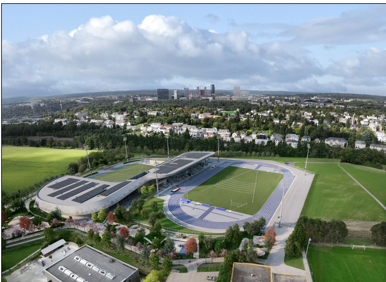
Vue aérienne depuis le sud-est
