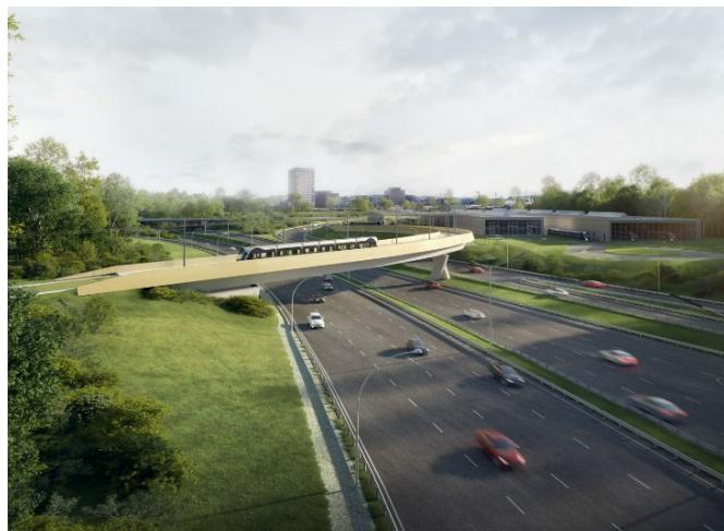
La construction du pont enjambant l’autoroute A1 marque une étape importante dans l’extension du tram jusqu’au Findel. Situé à une hauteur de 8 mètres au-dessus de l’autoroute, cet ouvrage d’art d’une longueur de 110 mètres et d’une largeur de 10 mètres, va accueillir la plateforme pour permettre au tram de rejoindre le Findel en site propre sur deux voies.
