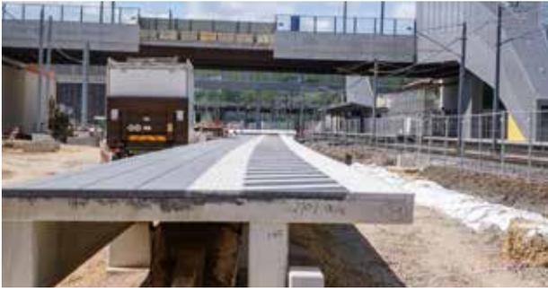
84 éléments d'un poids total de 1.000 tonnes forment le deuxième quai qui s'é élance sur 307 mètres. Il accueillera les deux voies de la ligne existante, le quai 1 celles de la nouvelle ligne (NBS).
