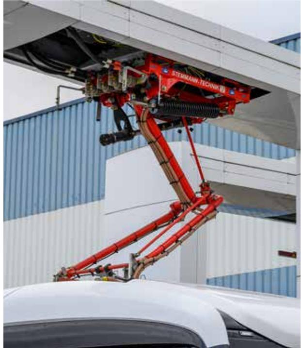
Au siège du Service Bus à Bonnevoie, deux pantographes ont été installés en tant que dispositif de chargement rapide.
