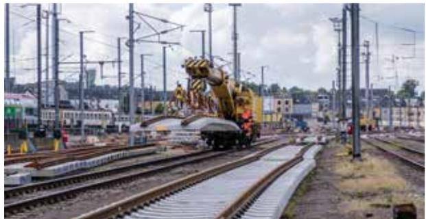
*Les traverses en bois ont été remplacées par de nouvelles traverses en béton d'une durée de vie de 40 à 50 ans, soit le double des anciennes.*
