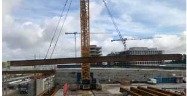
Des poutres de 80 et 30 tonnes ont été placées durant l'été sous l'égide de l'Administration des ponts et chaussées pour créer la deuxième voie de circulation du tramway surplombant les voies ferrées.
